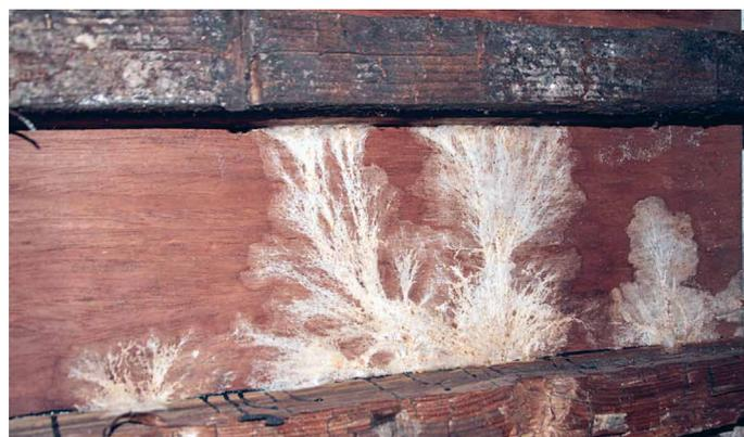
Abb. 2: Oberflächenmyzel Porenschwamm (*Antrodia* spp.) unter einem Holzfußbodenaufbau; Braunfäuleerreger
